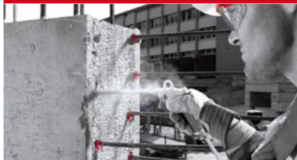
喜利得PROFIS Rebar 安装工具箱可快速、有效清除孔内的灰尘及混凝土碎石
