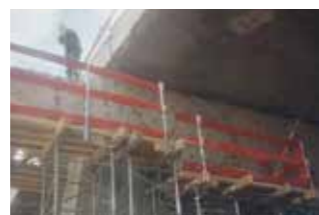
混凝土结构补强
