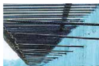
混凝土板加宽
