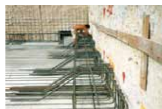
地下连续墙连接
