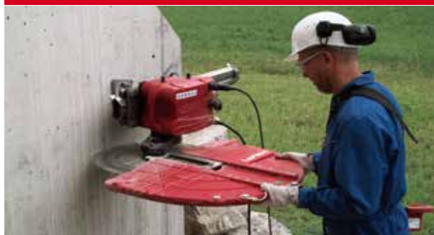
喜利得混凝土LP墙锯/WS链锯系统可快速、安全、准确地切割按施工所要求的构件
